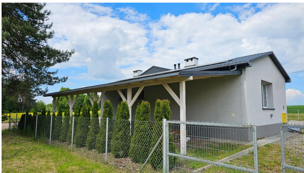
Zadaszenie jednospadowe przy świetlicy wiejskiej w miejscowości Stójło. Źródło: Opracowanie własne
