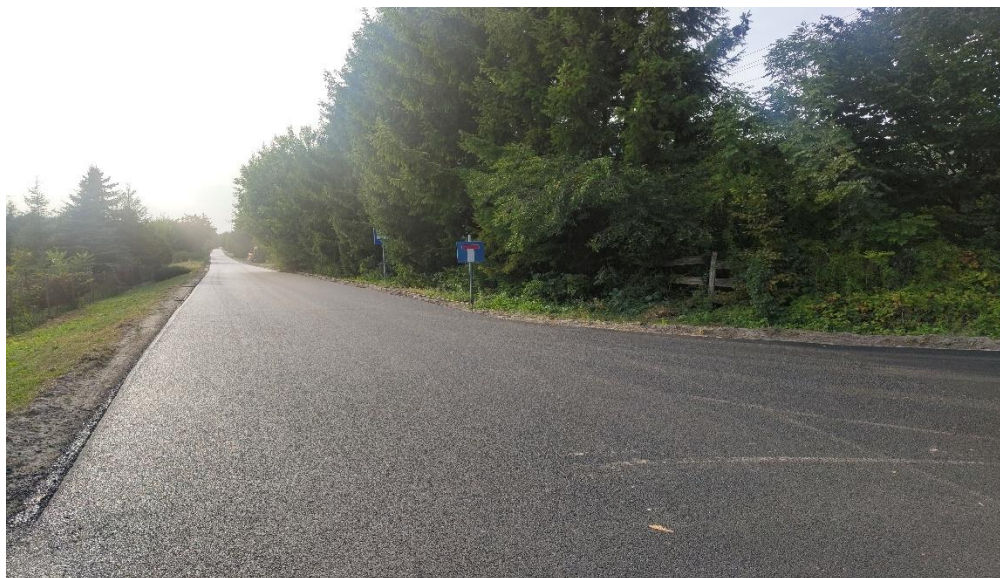
Wyremontowana droga w miejscowości Stójło
