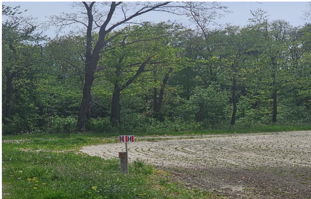
Wodociąg w miejscowości Zwierzyniec.
